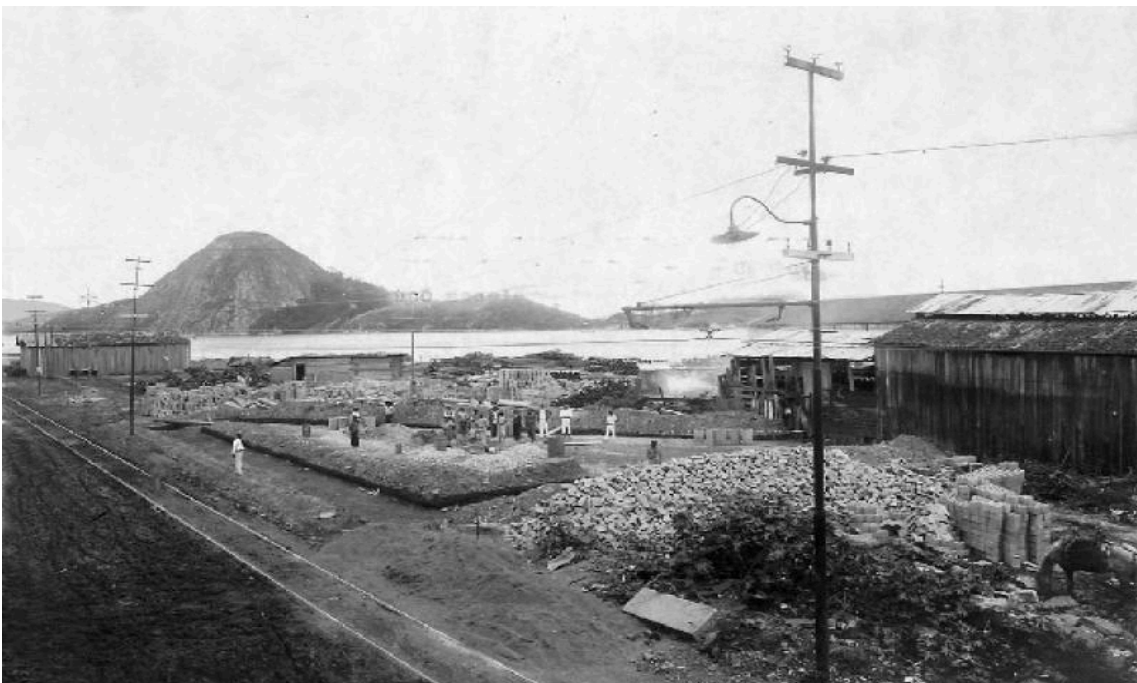
Figura 4 - Preparação do terreno para a construção do Grupo Escolar Gomes Cardim - 1925
