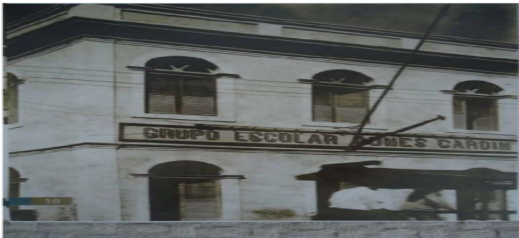
Figura 2 - Grupo Escolar Gomes Cardim, situado na Rua Pereira Pinto nº 18
