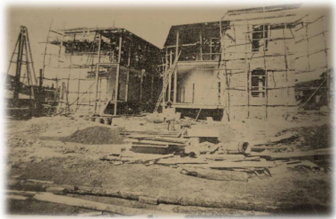
Figura 5 - Grupo Escolar Gomes Cardim em construção - 1925
