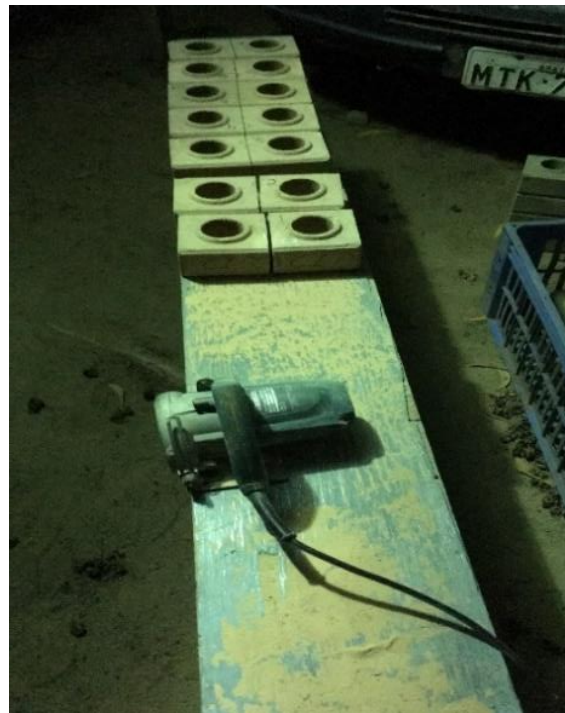
Figura 31 – Corte dos tijolos.
