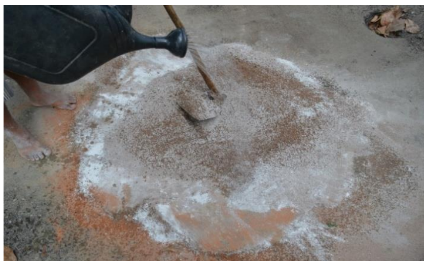
Figura 24 – Mistura sendo homogeneizada e hidratada durante o preparo.
