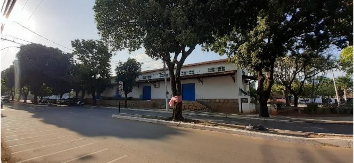
Figura 47 – Antigo Terminal de cargas da EFVM e atual biblioteca municipal de Colatina, em 2022
