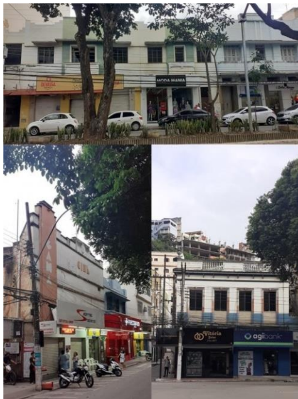
Figura 36 – Placas publicitárias recobrando as edificações históricas na Avenida Getúlio Vargas
