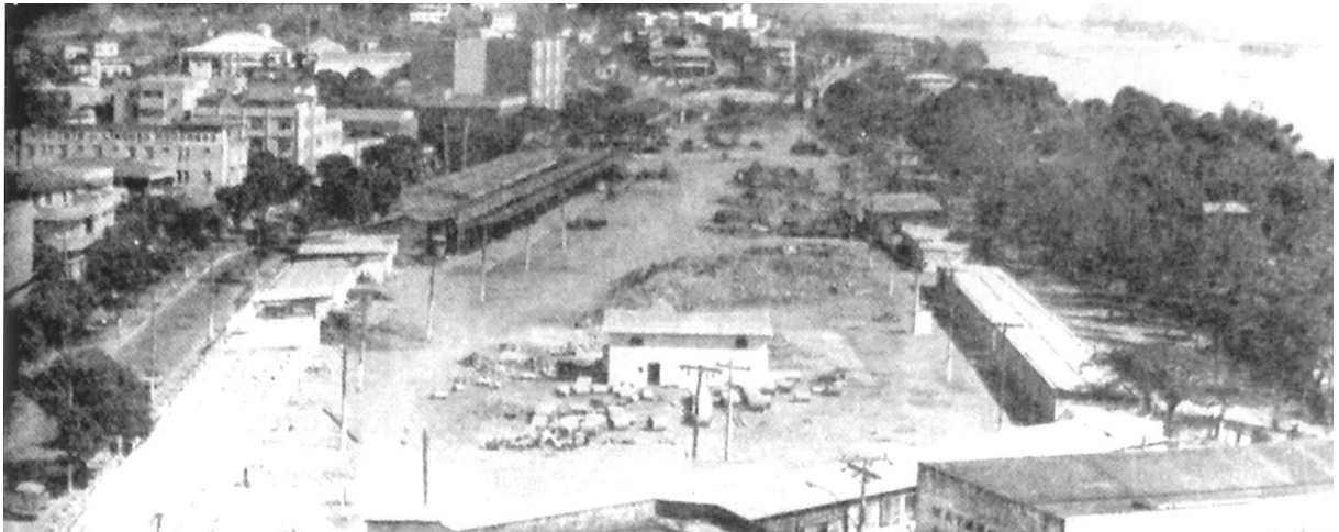
Figura 41 – Construção da Praça Sol Poente
