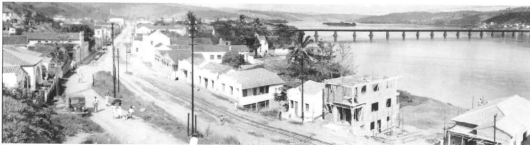
Figura 2 – Traçado da linha férrea passando pela Avenida Getúlio Vargas paralela ao Rio Doce
