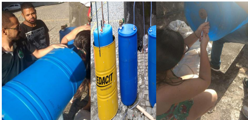
Figura 10.2 — Construção dos biodigestores e do gasômetro pelos alunos
