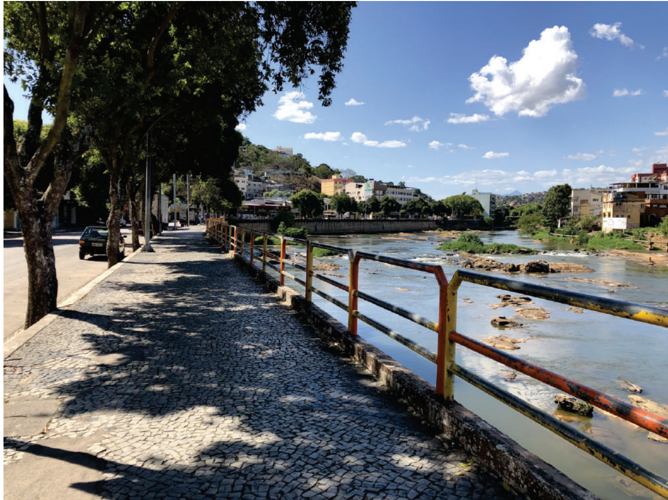
Figura 21 – Calçada da Avenida Beira Rio antes da reforma
