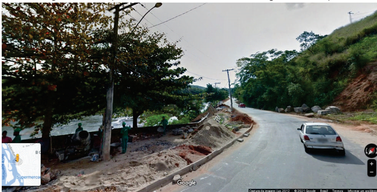
Figura 30 – Calçadão da Avenida Carlos Lindenberg em construção
