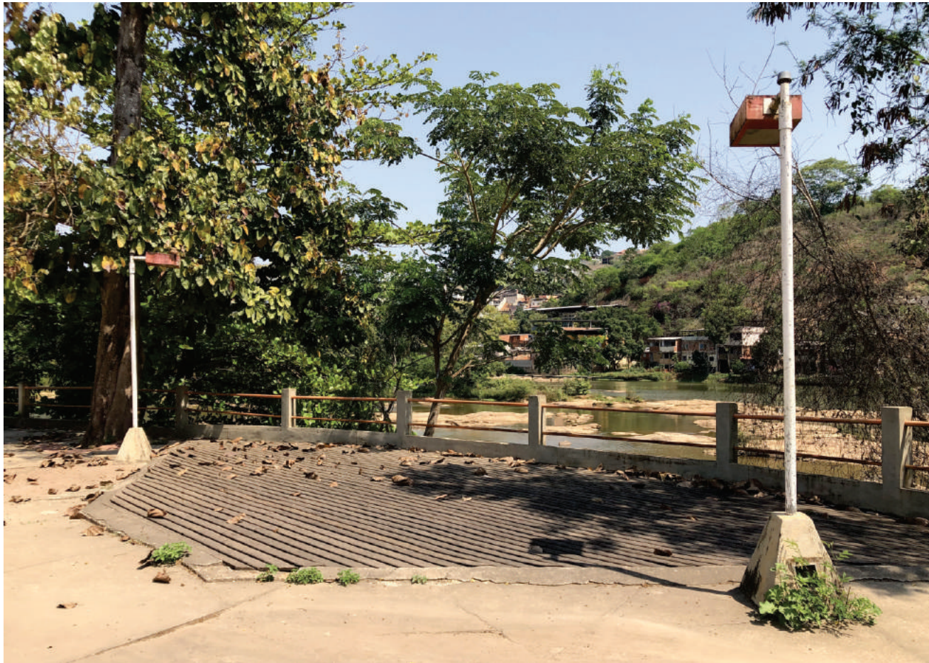
Figura 50 – Deck de madeira na Avenida Carlos Lindenberg
