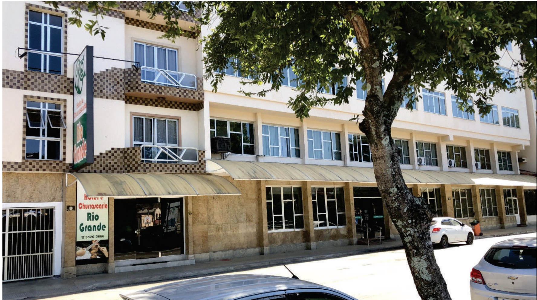
Figura 40 – Restaurante e hotel Rio Grande na Avenida Beira Rio
