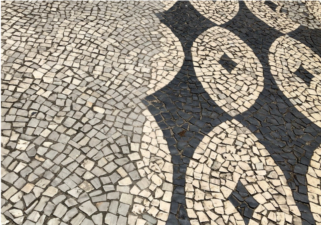
Figura 20 – Pedras portuguesas no calçadão da Avenida Beira Rio
