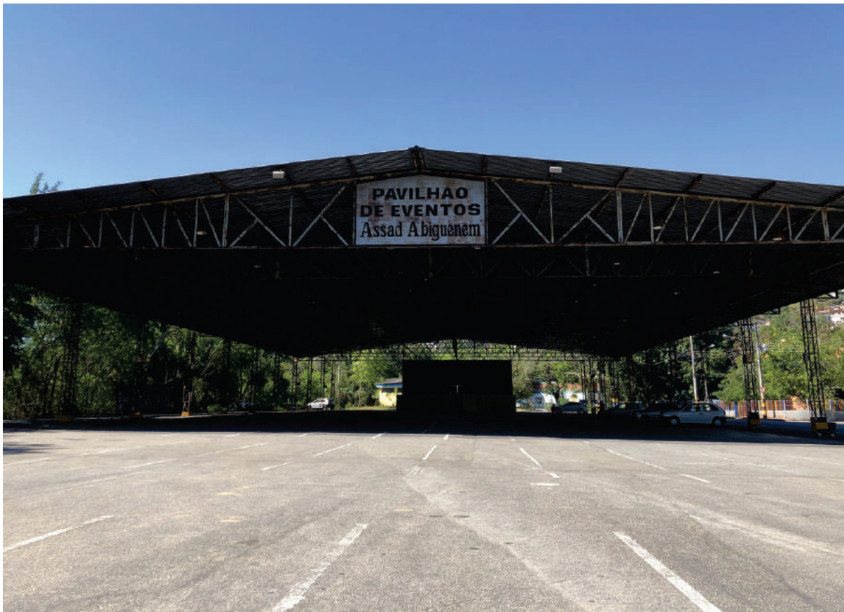
Figura 25 – Pavilhão de Eventos Assad Abiguenem
