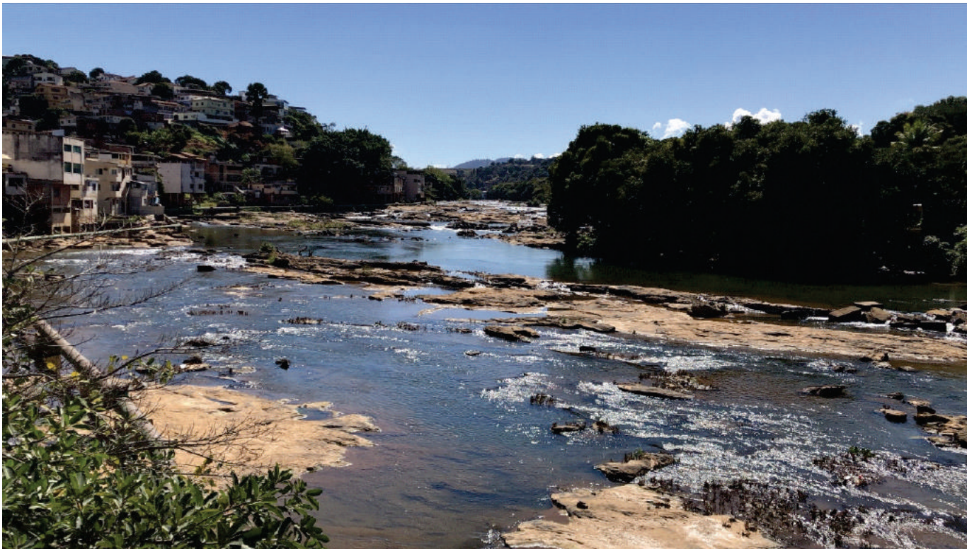
Figura 31 – Rio Itapemirim visto da Ponte Guadalajara
