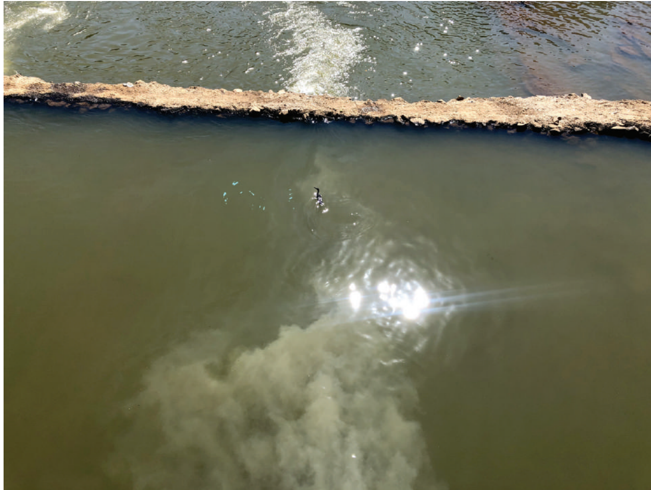
Figura 43 – Esgoto sendo despejado diretamente no rio Itapemirim no Centro da cidade
