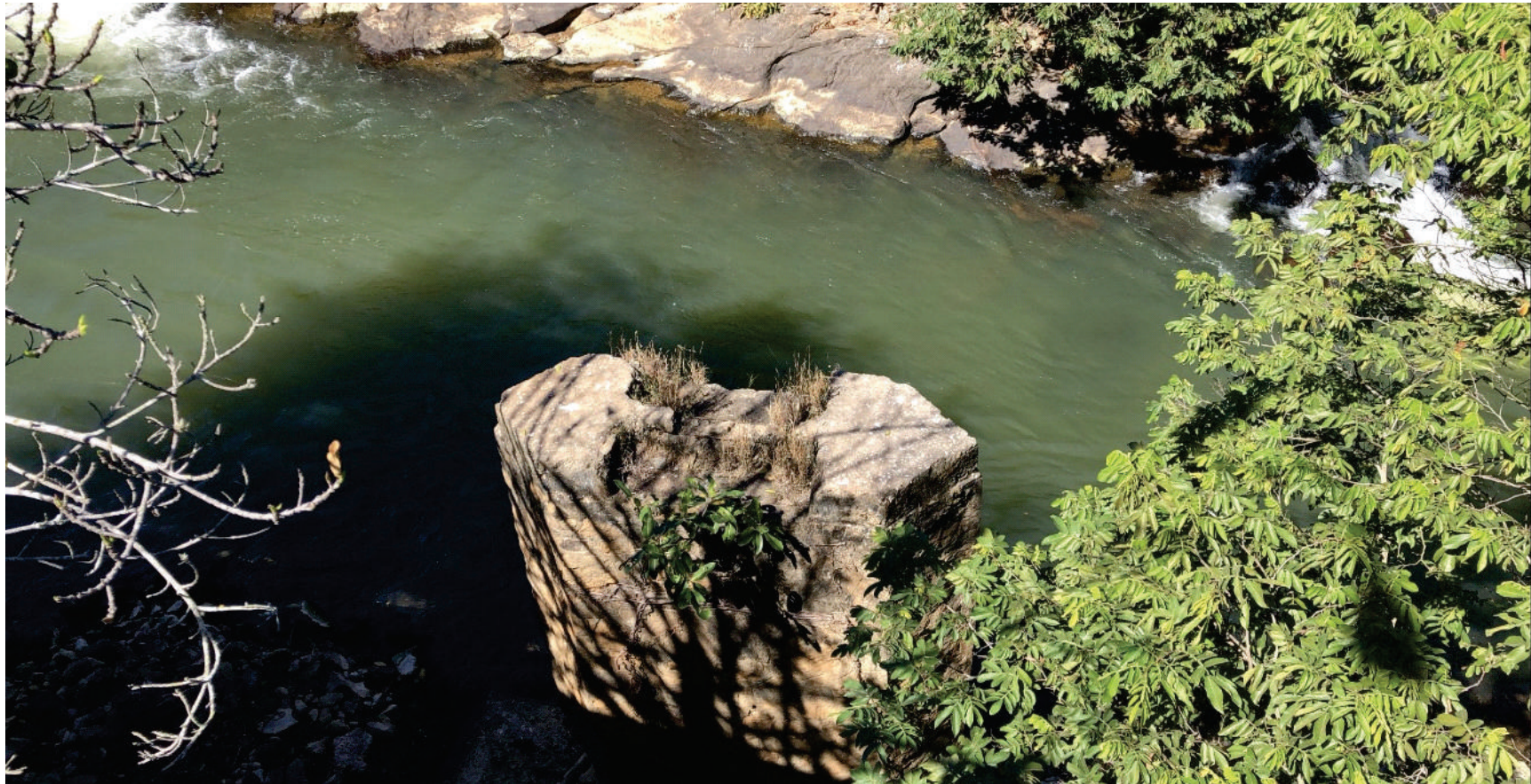
Figura 11 – Ruínas da antiga ponte de madeira
