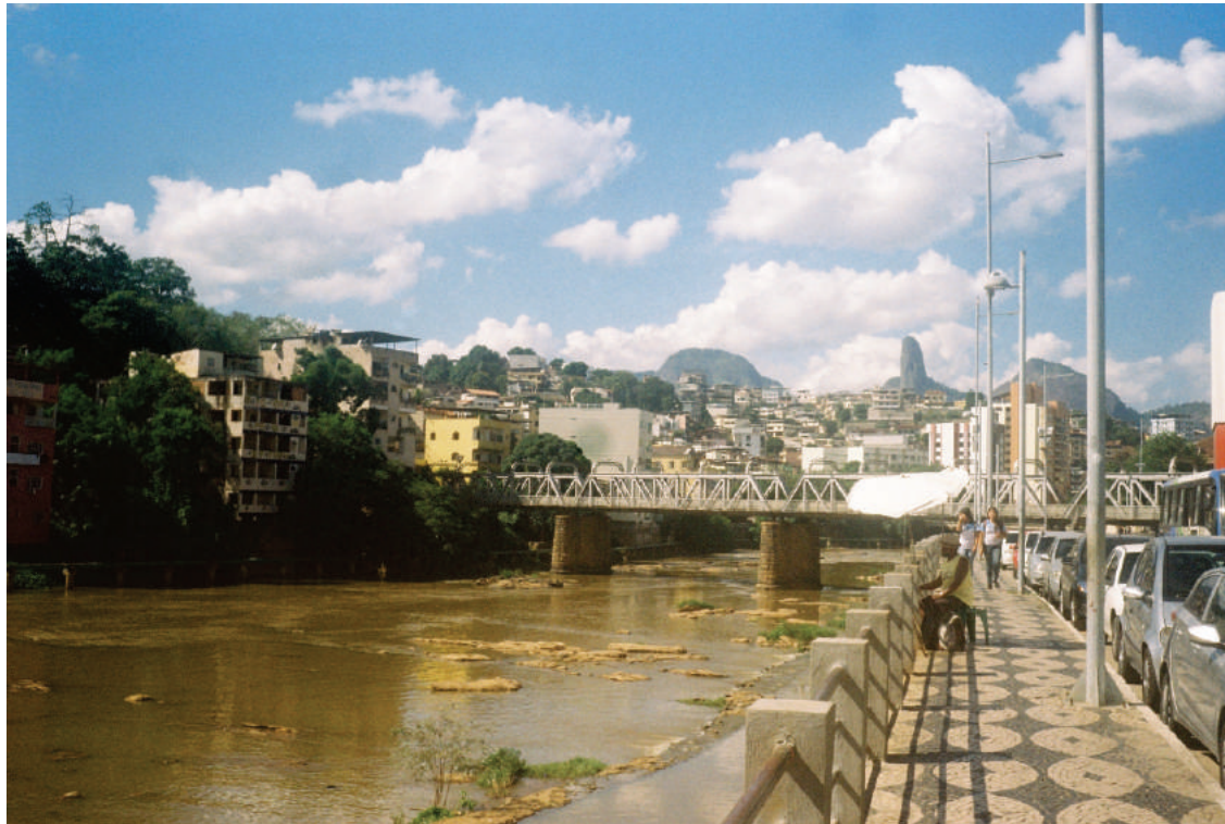
Figura 4 – Ponte de Ferro vista ao fundo na Avenida Beira Rio
