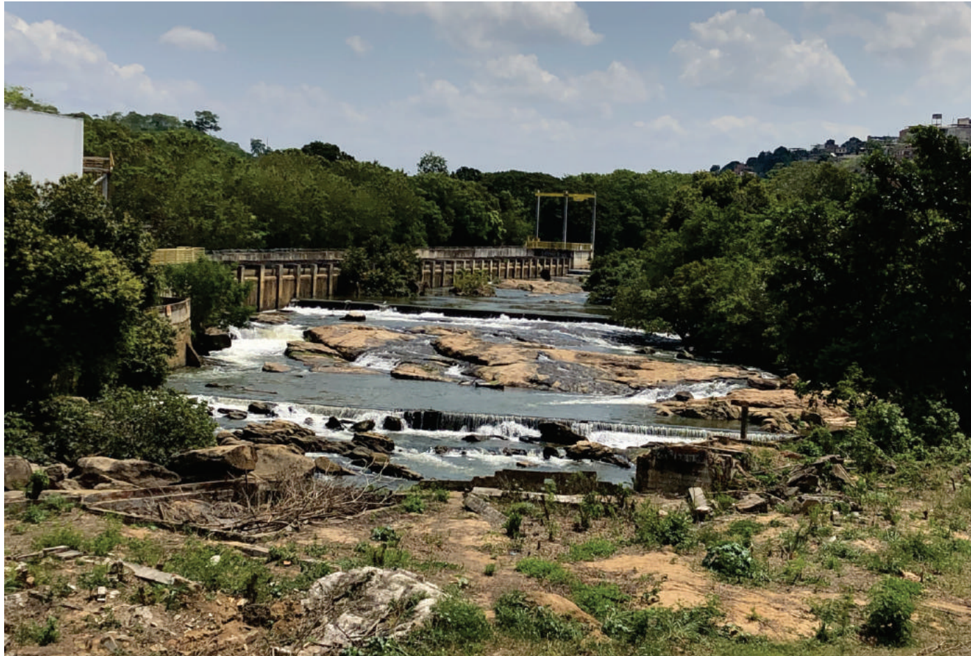
Figura 59 – Rio Itapemirim visto da Avenida Carlos Lindenberg
