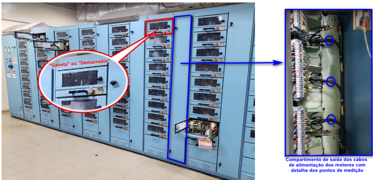
Figura 20 – Detalhe construtivo do CCM.
