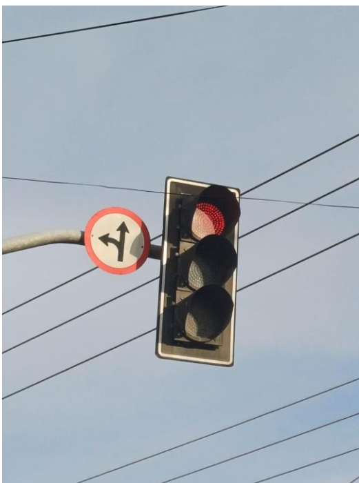
Figura 1 - Semáforo veicular com focos circulares de 300 milímetros
