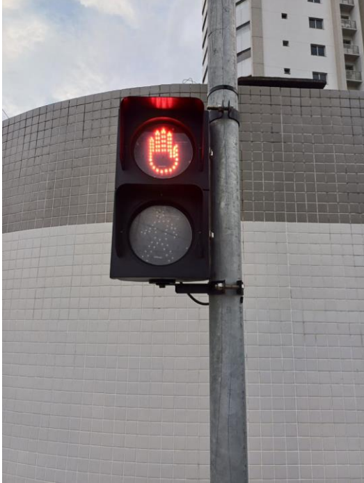
Figura 3 - Semáforo de pedestre com focos circulares de 200 milímetros com pictogramas
