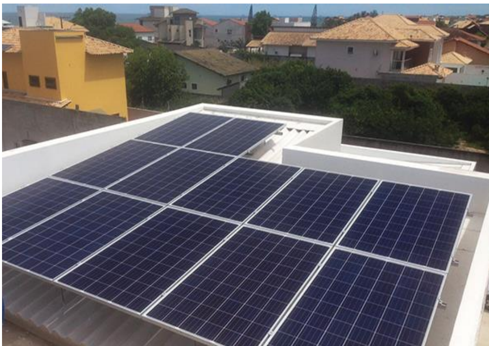
Figura 6 – Módulos fotovoltaicos.
