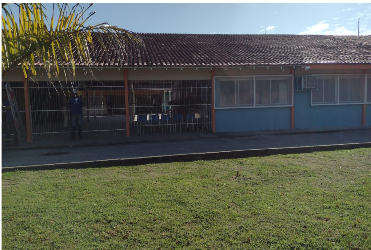
Figura 1: Fotografia da parte frontal da EEEFM Córrego de Santa Maria
