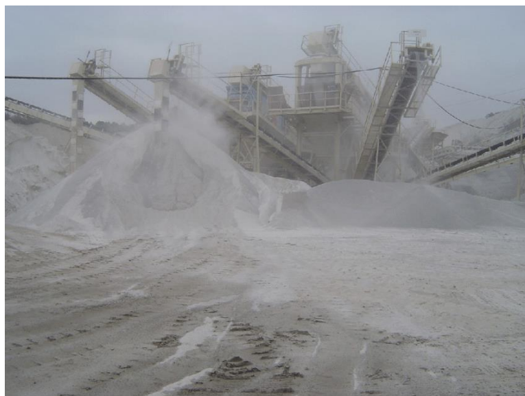
Figura 8 – Pilha de pó de pedra
