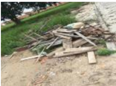
Figura 2 - Ponto A antes da limpeza
