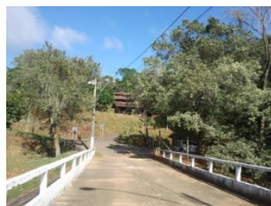
Barragem da represa
